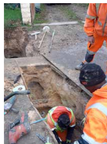
Réfection d'un branchement
