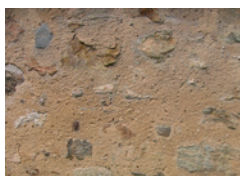
Jointoiement à pierres vues
